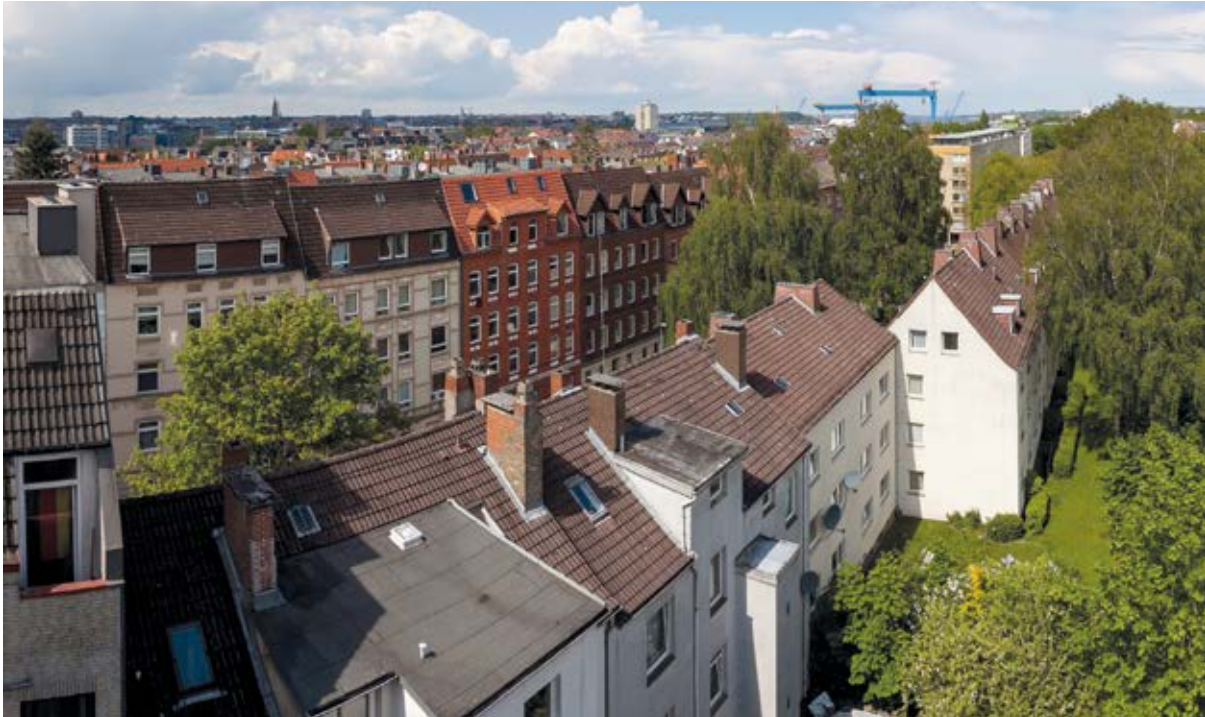
Dachausbau mit konstruktiver und gestalterischer Qualität (© WohnWert Gaarden - Kooperation im Quartier Haus & Grund Verein Kiel)
